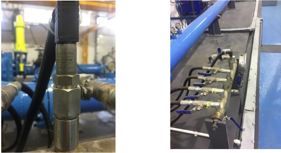
Şekil 4.2. Basınç sensörü ve kollektör
