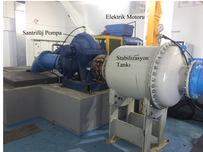
Şekil 4.14. Santrifüj pompa grubu
